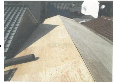
構造用合板で見えないところも頑丈に。この上に屋根材を葺きます。
