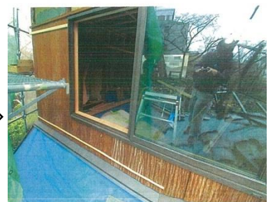
修繕した外壁が雨や風から建物を守ります。
