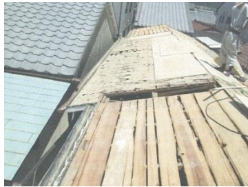
屋根の下地を調べてみれば、こんな構造になっています。
