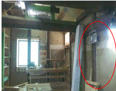
中塗りまで除去して、下地から健全な状態にします。
