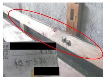
足固めの設置完了です。これで地震時でも簡単に柱がずれません。
