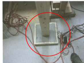
礎石の周りを鉄筋コンクリートで固め、礎石の沈下を防止します。
