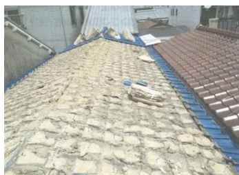
瓦の葺き土が一面に載っています。これを降ろすだけでも軽量化になります。
