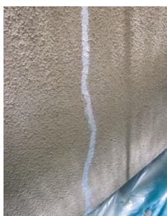
傷んだ箇所を補修し、外壁を仕上げます。
