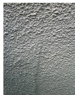
修繕した外壁が雨や風から建物を守ります。
