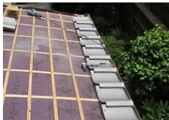
葺き土を降ろして新しい屋根材にします。
