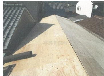
構造用合板で見えないところも頑丈に。この上に屋根材を葺きます。
