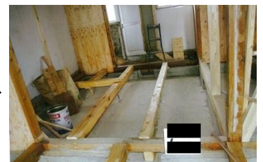
これで、防蟻対策の完了です。
