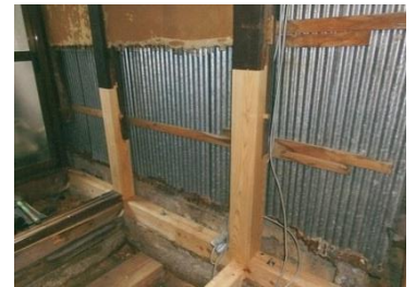
これで健全化の完成です。金物で正しく補強をすれば安心です。
