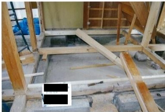
土台、柱の劣化の修繕の追加工事が完了しました。
