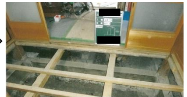
これで基礎の有筋化の完成です。
