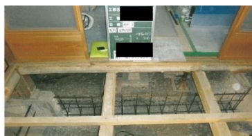
今ある基礎に有筋の基礎を増設したり造り替えます。
