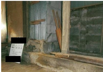
経年劣化やシロアリ被害などにより、柱・土台が傷んでいます。
