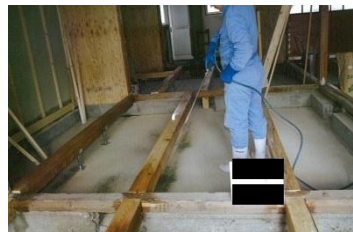
このままでは、害虫がつきやすいので、薬剤散布、注入等を行います。
