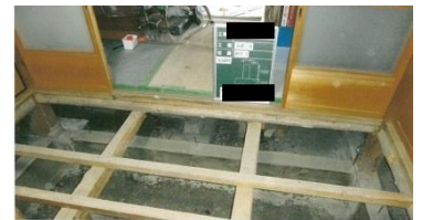
これで基礎の有筋化の完成です。
