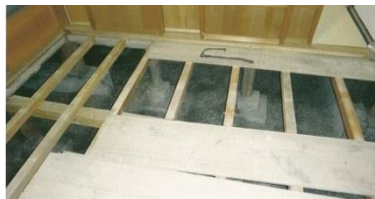
無筋の基礎やコンクリートブロック基礎のままでは耐震性UPにはなりません。
