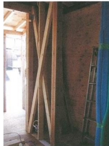
今ある壁を強くしたり、新たに丈夫な壁を造ったりします。
