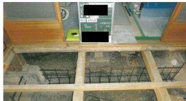
今ある基礎に有筋の基礎を増設したり造り替えをします。
