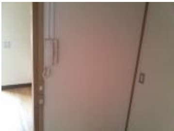
〈居間・緊急通報装置〉
