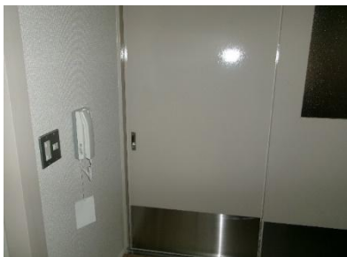
＜居間・緊急通報装置＞
